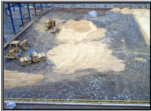
Figura 4.8. Tendido de pedraplén.
