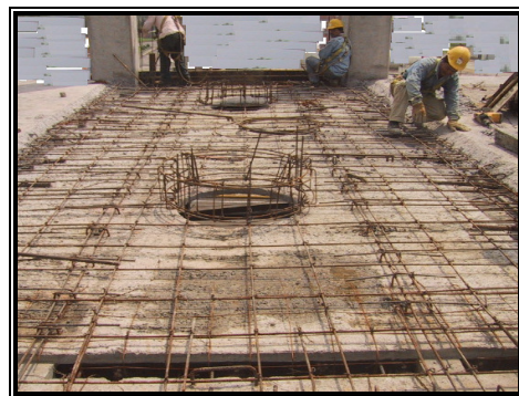
Figura 4.25. Refuerzo en capa de compresión.
