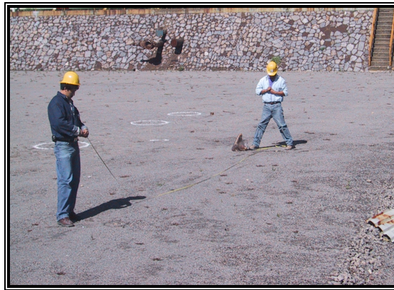
Figura 4.12. Trazos para ubicación de pilas.
