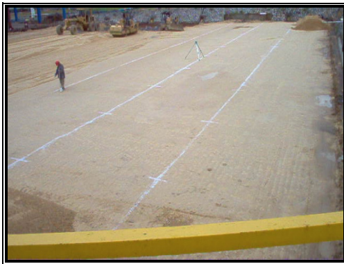
Figura 4.10. Nivelación de capa base.
