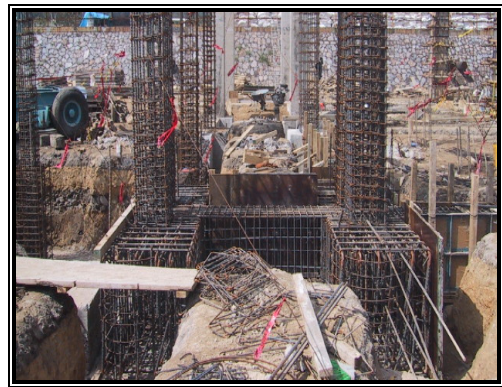
Figura 4.18. Refuerzo de dados-columnas.
