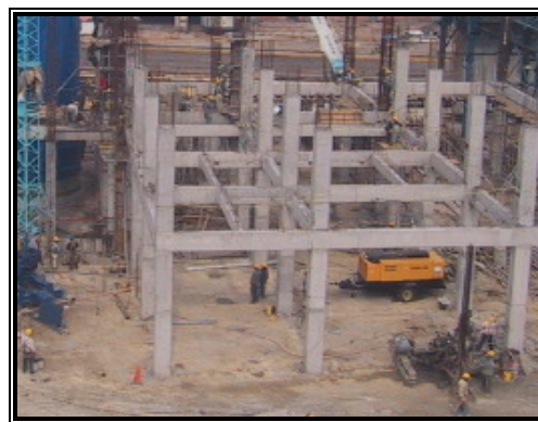
Figura 4.21. Columnas y trabes terminadas.
