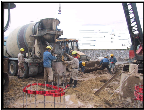
Figura 4.15. Colado de pilas.
