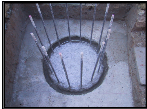
Figura 4.16. Preparación para desplante de dados.
