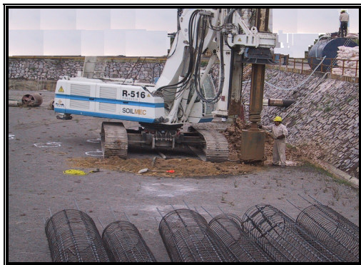
Figura 4.13. Perforación de pilas.
