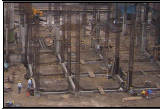
Figura 4.19. Distribución de refuerzo en columnas.
