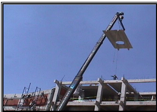
Figura 4.24. Montaje de losa prefabricada TT.
