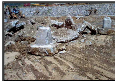
Figura 4.4. Extracción de cimentaciones.
