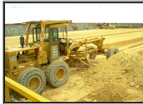
Figura 4.9. Tendido de capa sub – base.
