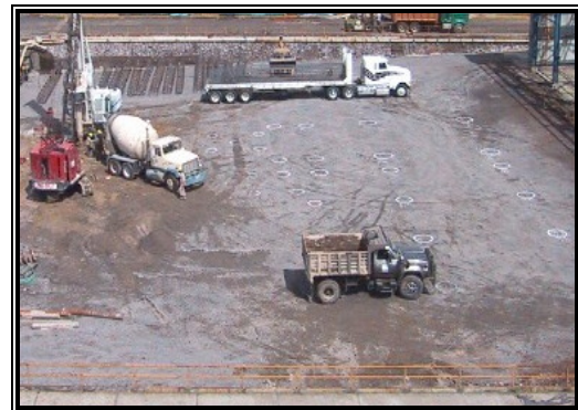
Figura 4.14. Perforación y colado de pilas.
